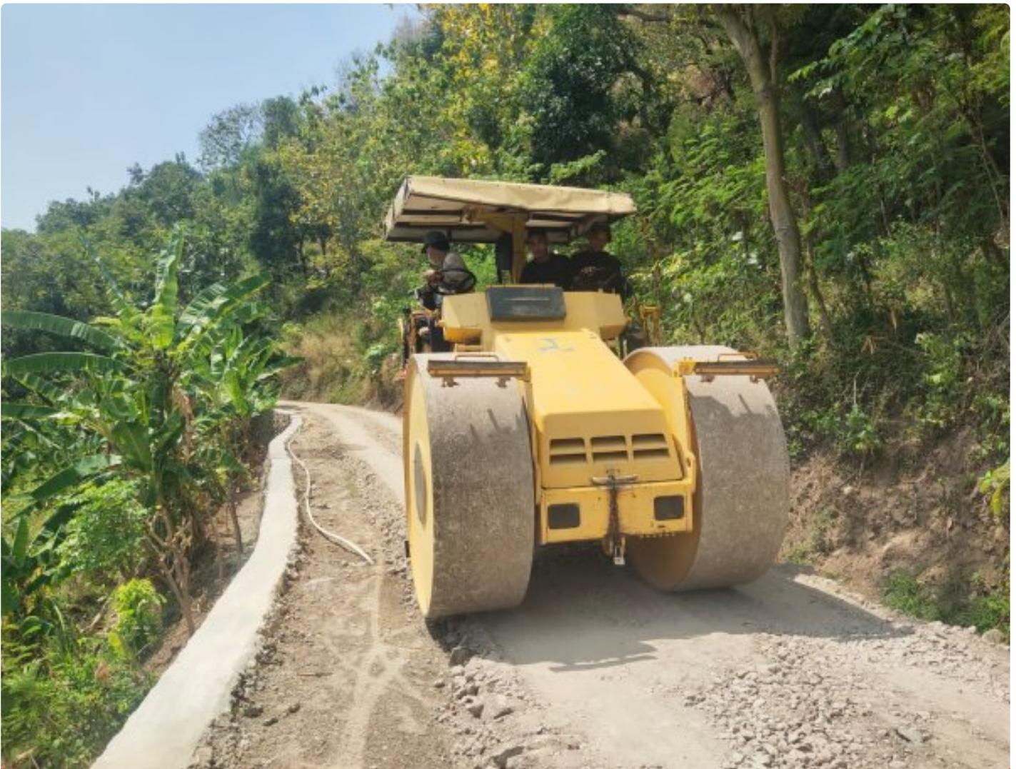
*Foto: Penggunaan Alat Berat Silinder proses pengerjaan pemadatan Jalan TMMD Reg -121 Kodim 0720/Rembang di Desa Labuhan Kidul Kecamatan Sluke, Kabupaten Rembang, Jawa Tengah, Selasa (13/08/2024).*
